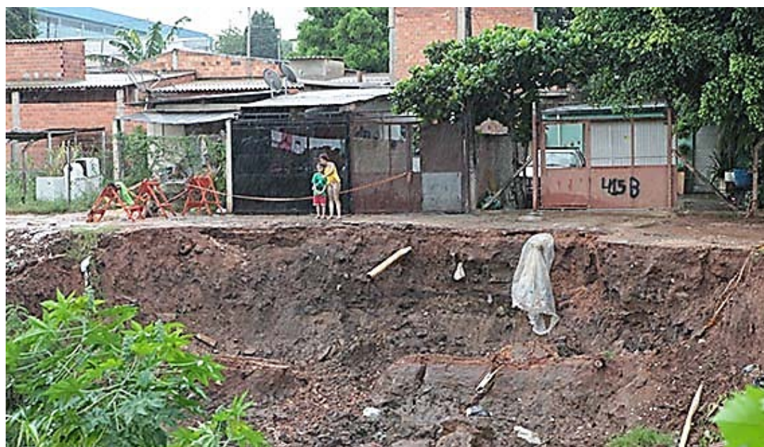
Figura 237 - Desabamento em ocupação da Área Verde do Jardim Nova Terra, na Região do Matão
