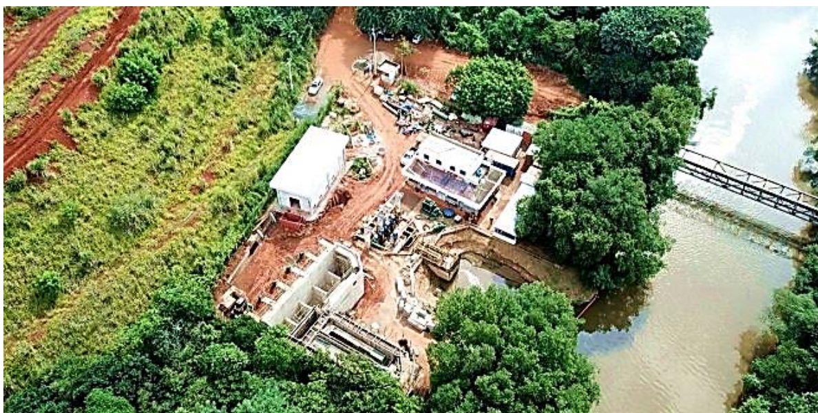
Figura 229– Captação de Água no Rio Atibaia
