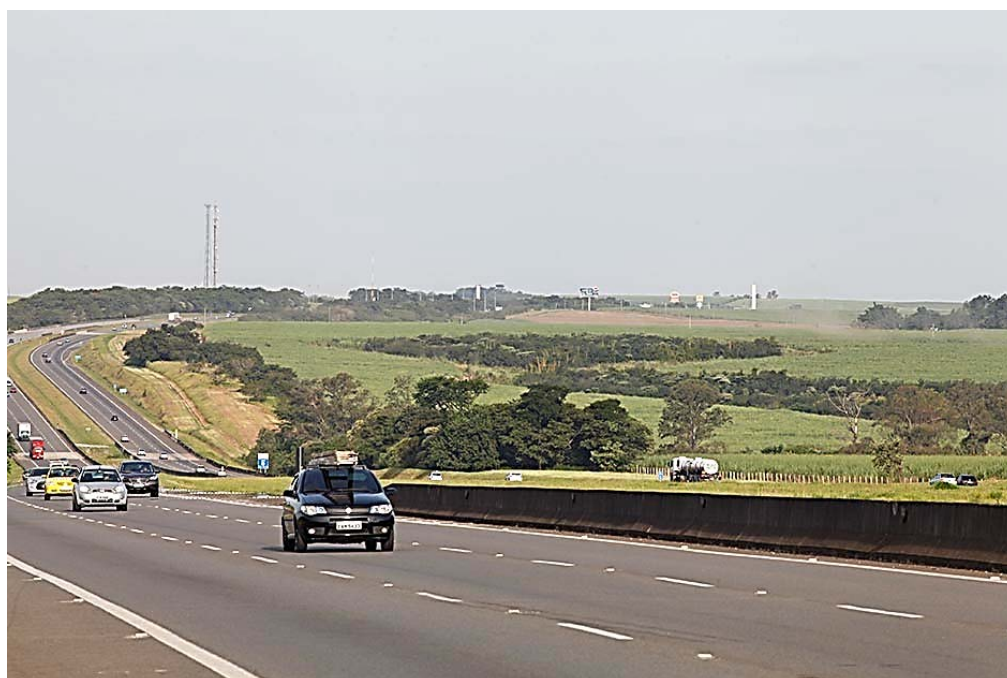
Figura 216 – Rodovia dos Bandeirantes passando em Sumaré
