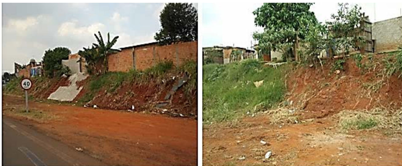
Figura 238- Desabamento em ocupação na área que fica as margens da Estrada Municipal Américo Ribeiro dos Santos, no bairro Jardim Aclimação
