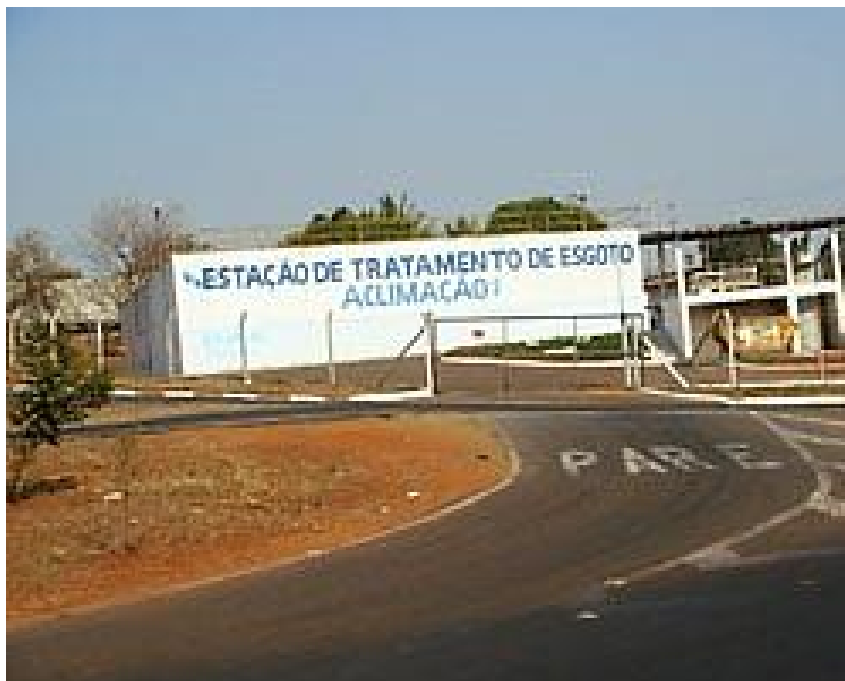
Figura 226 – ETE Jd Aclimação Fonte: Hidrosum Engenharia Sanitária
