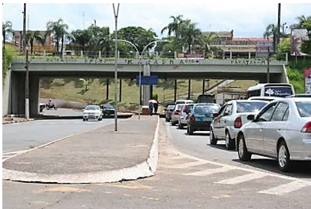
Figura 203 – Viaduto Comendador Aristides Moranza
