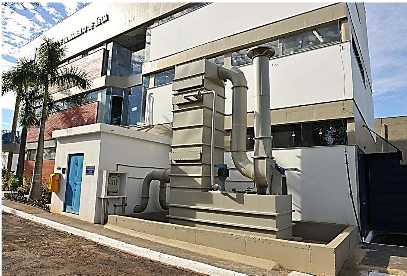
Figura 220 – ETA II Reservatório – Pq Itália
