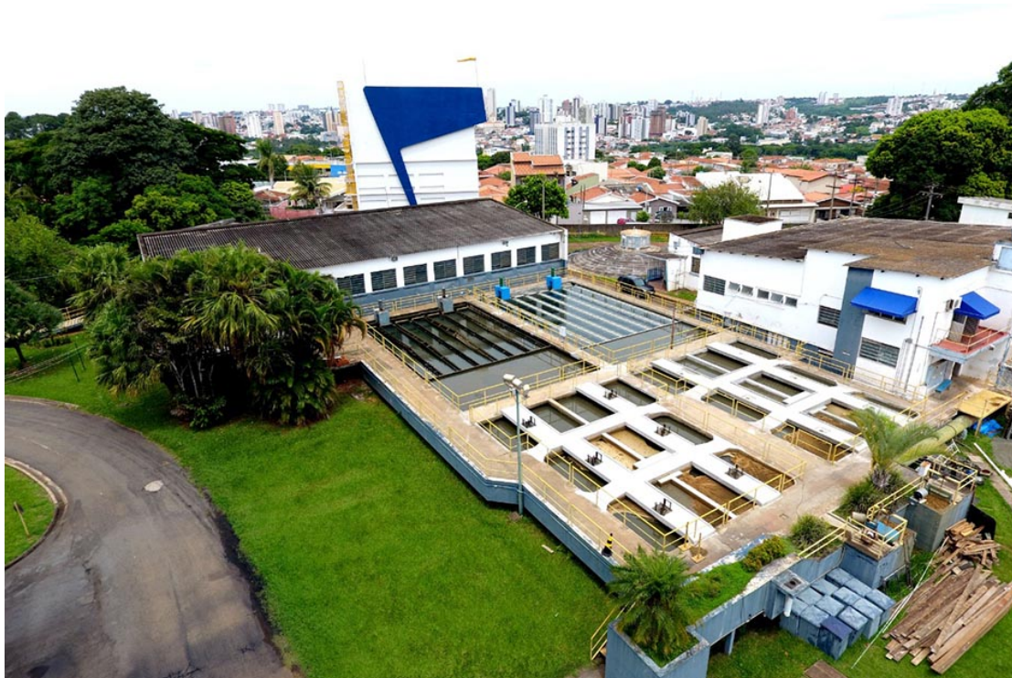
Figura 219– ETA I – Vila Miranda
