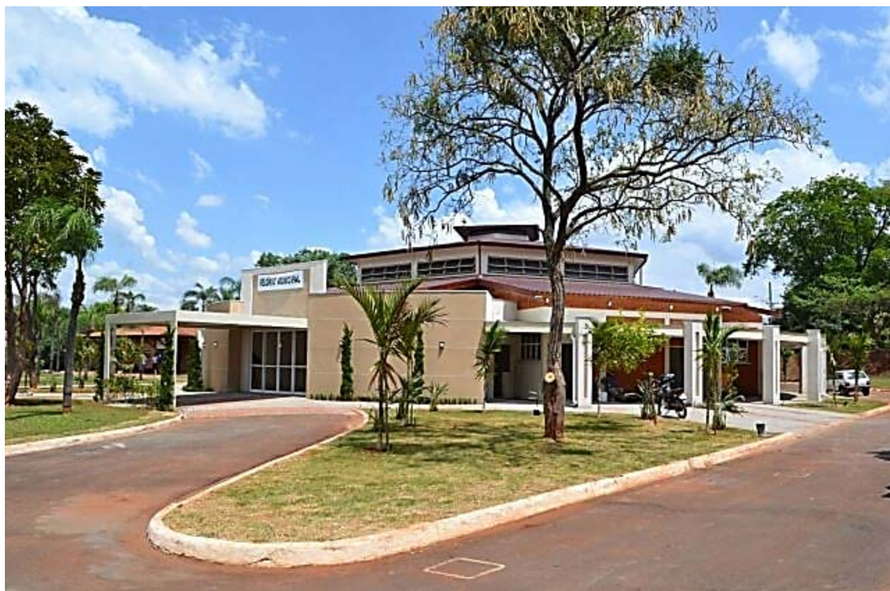
Figura 244 – Fachada do Velório Municipal
