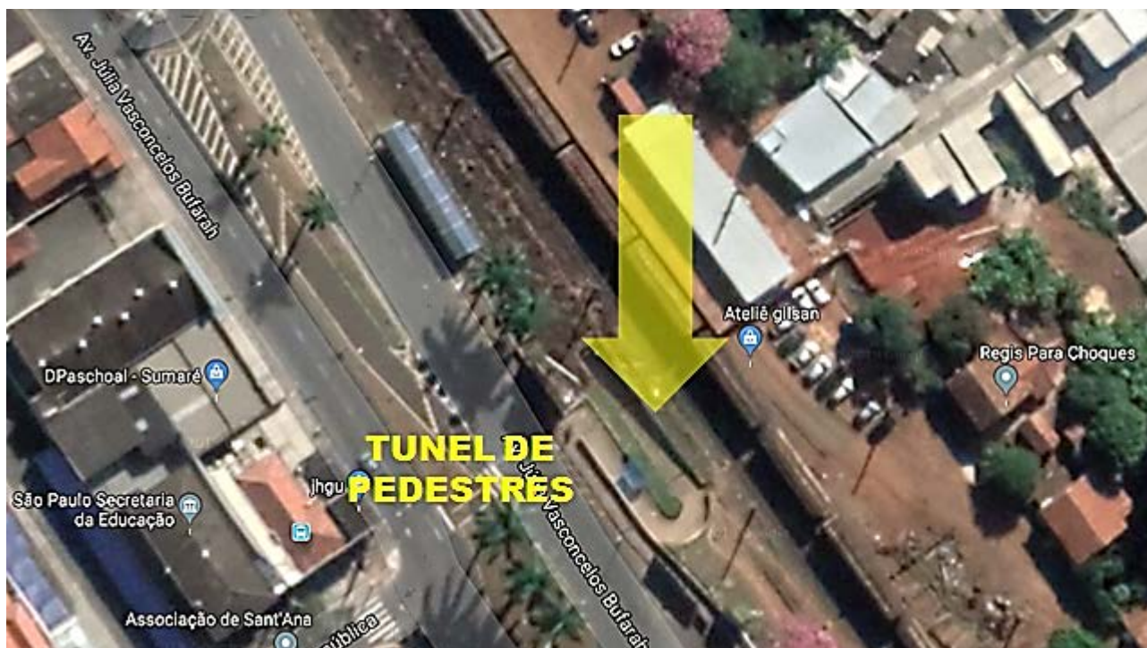
Figura 202 – Túnel de travessia dos pedestres - vista aérea
